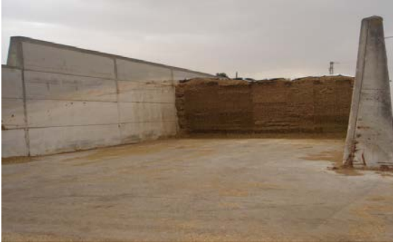
Betonarme silolar
